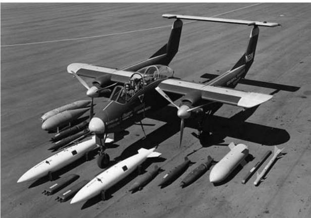
Самолет Конвэр 48 с выкладкой вооружения
